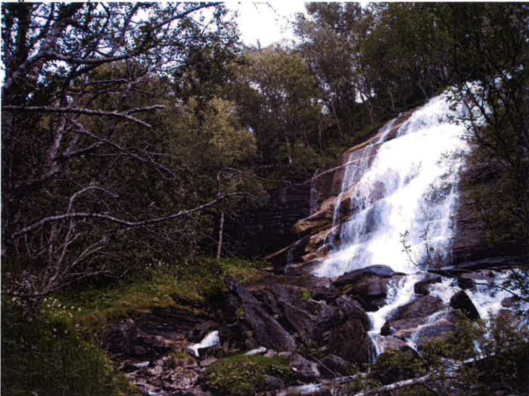
Foss ved planlagt kraftstasjon. Dato 30.august 2012. Estimert vannføring på 0,1 m 3 /s. (Foto: Jon Larsen)
