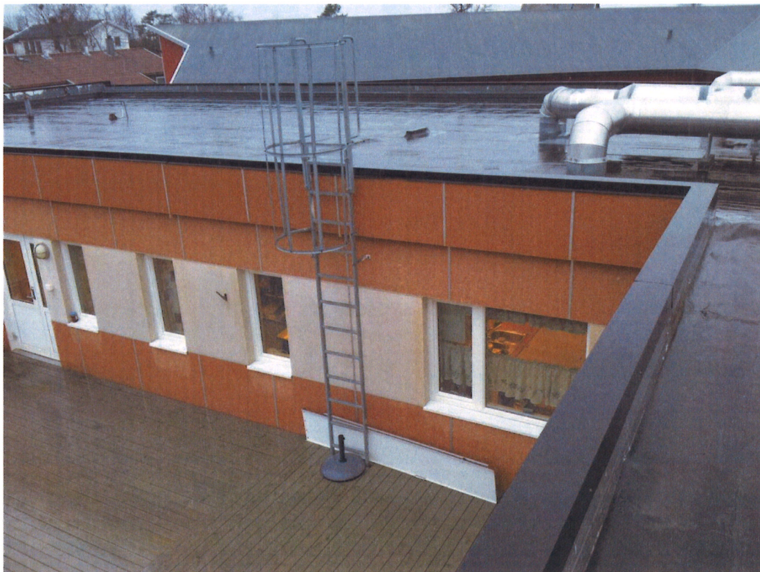
Oversikt tak. Yttervegger og flatt tak med gesimser på gammel del og skråtak på ny del vises.
