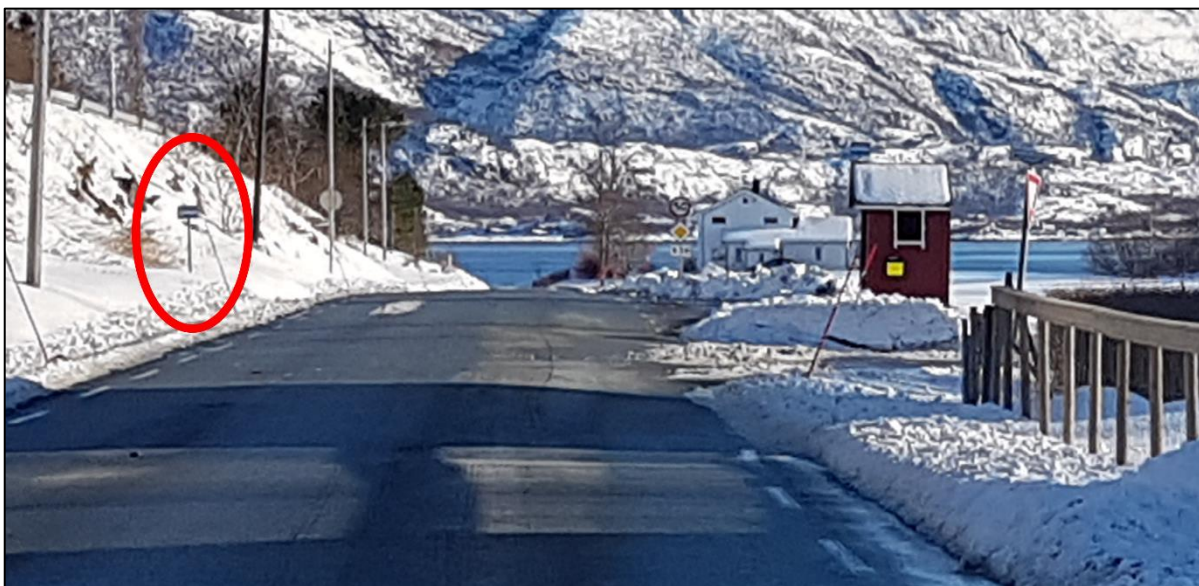
Figur 4 Holdeplass Kvithammerlia. Holdeplasskilt markert i rødt til venstre i bildet er stopp øst for Fv 838. Det er ingen tilrettelagt venteplass for passasjerer på denne siden av veien. Lehus til høyre i bildet.
