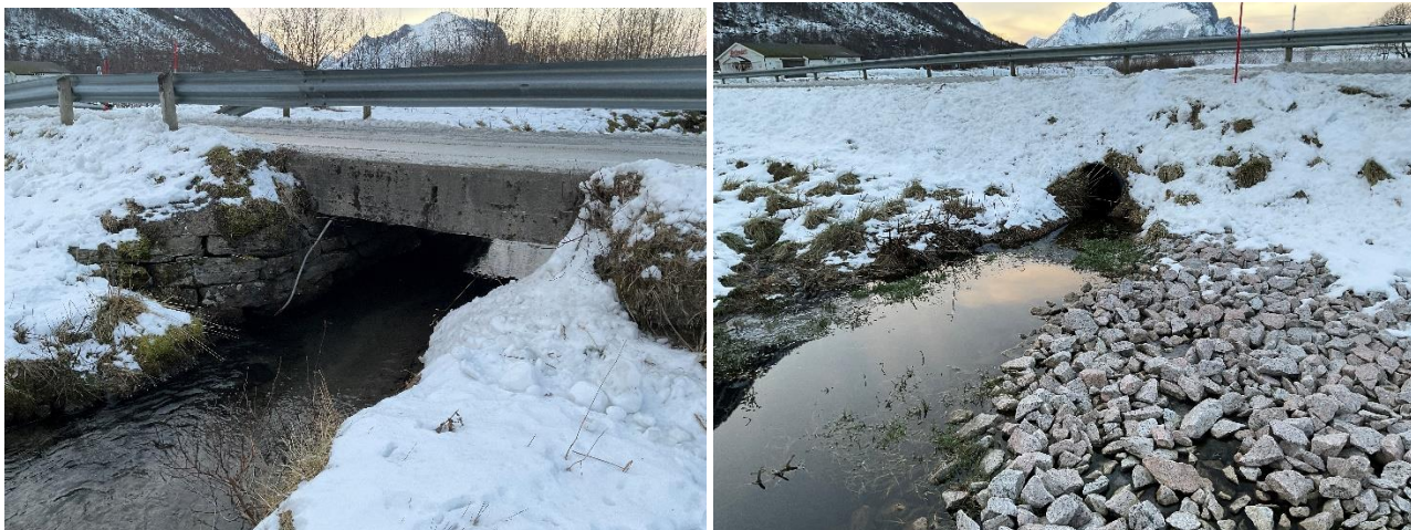
Figur 7 Bru og kulvert under Strandveien.
