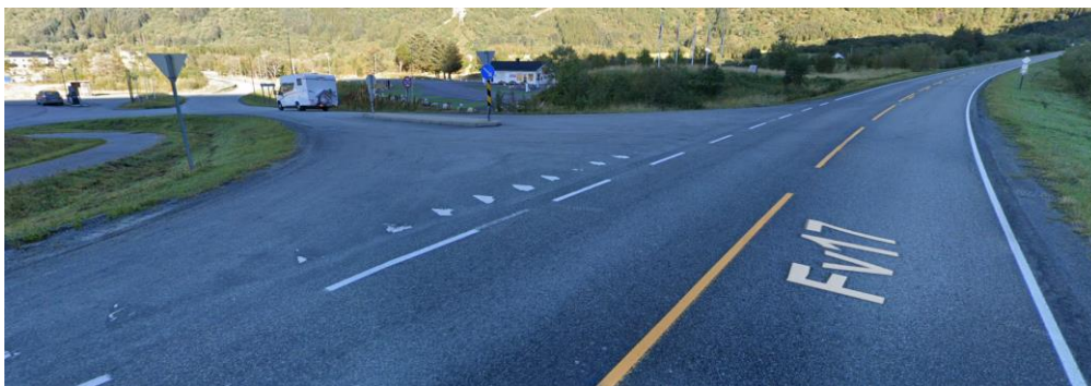
Figur 2-3: Kryss mellom fv. 17 og fv. 7436 fra Google Street View.
