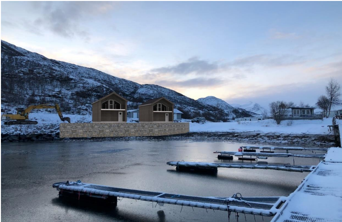
Vik mot nord med fylling i sjø (R7)
