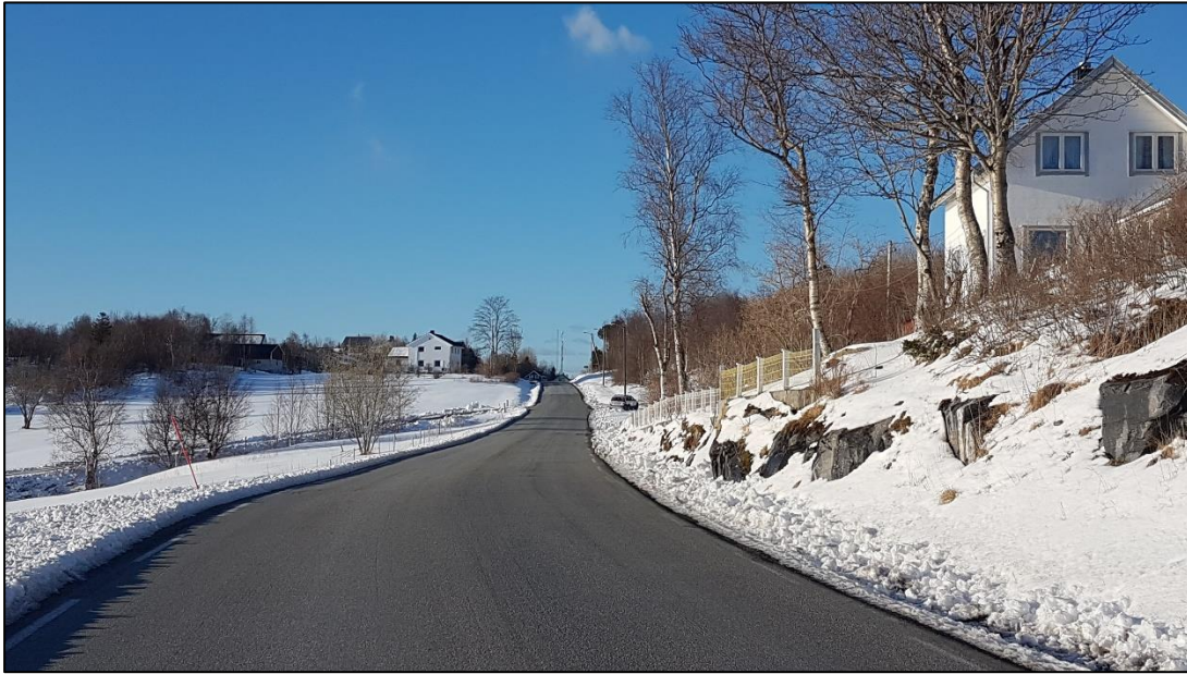
Figur 9: Fra Oldervika. Gang- og sykkelvegen er foreslått lagt langs vestsiden av Fv. 838 (t.v. på bildet)
