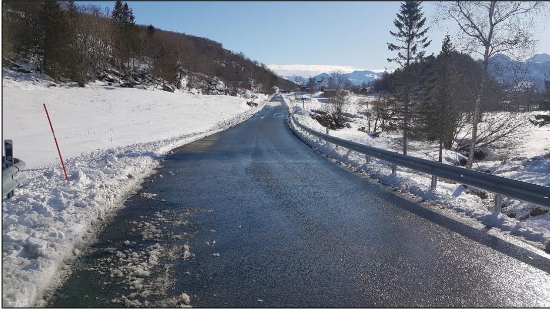
Figur 6: Den nordligste delen av planområdet ved Flathaugen. Gang- og sykkelvegen planlegges lagt langs vestsiden av Fv. 838 (til høyre).
