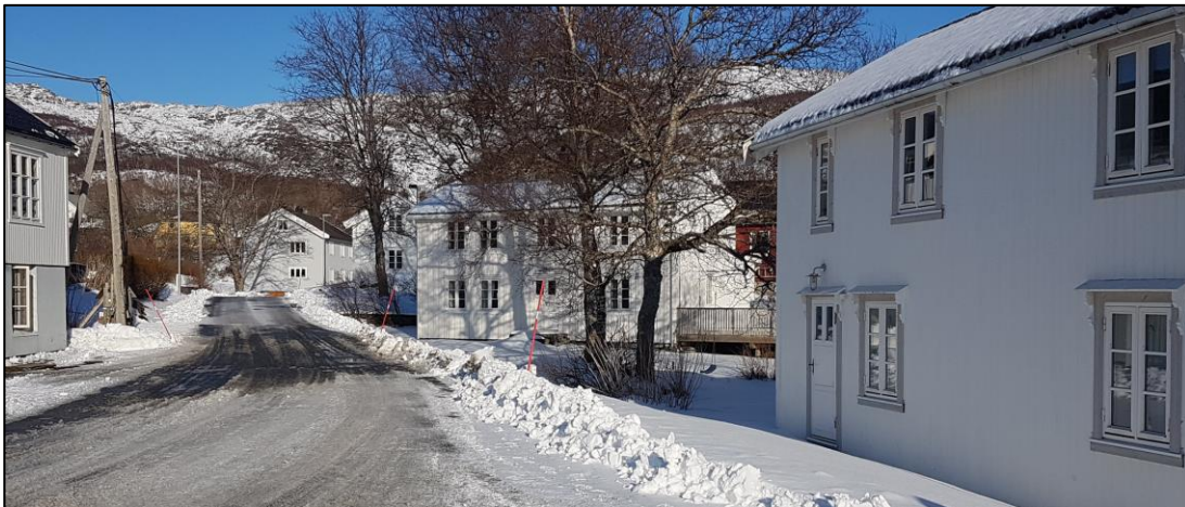
Figur 7: Fra den verneverdige bebyggelsen ved Inndyrsvågen.
