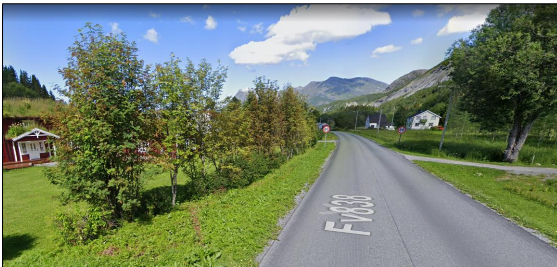
Figur 19: Ved Inndyrvegen 122 er det plantet en rad med trær og busker som er positiv for vegrommet og danner en skjerm mot fylkesvegen. Denne må tas vekk når gang/sykkelvegen blir bygd. Foto: Google.
